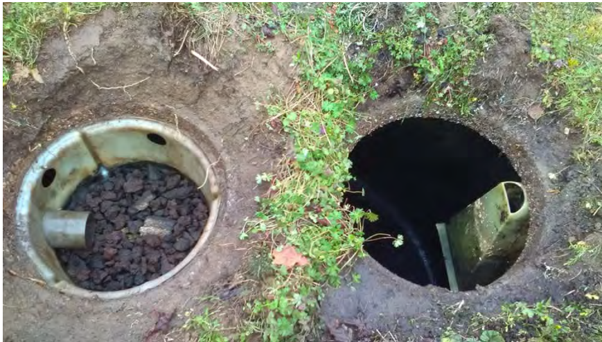
Fosse toutes eaux – vidange en cours
