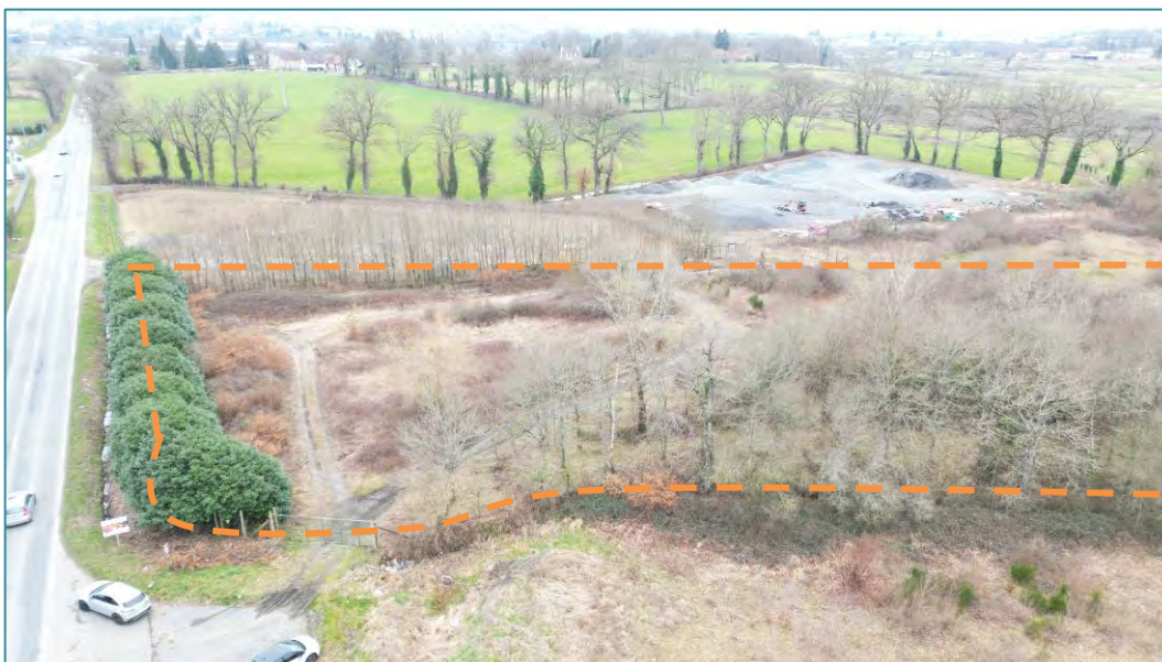
Vue de puis l'Est du périmètre du site - © CAMPUS
