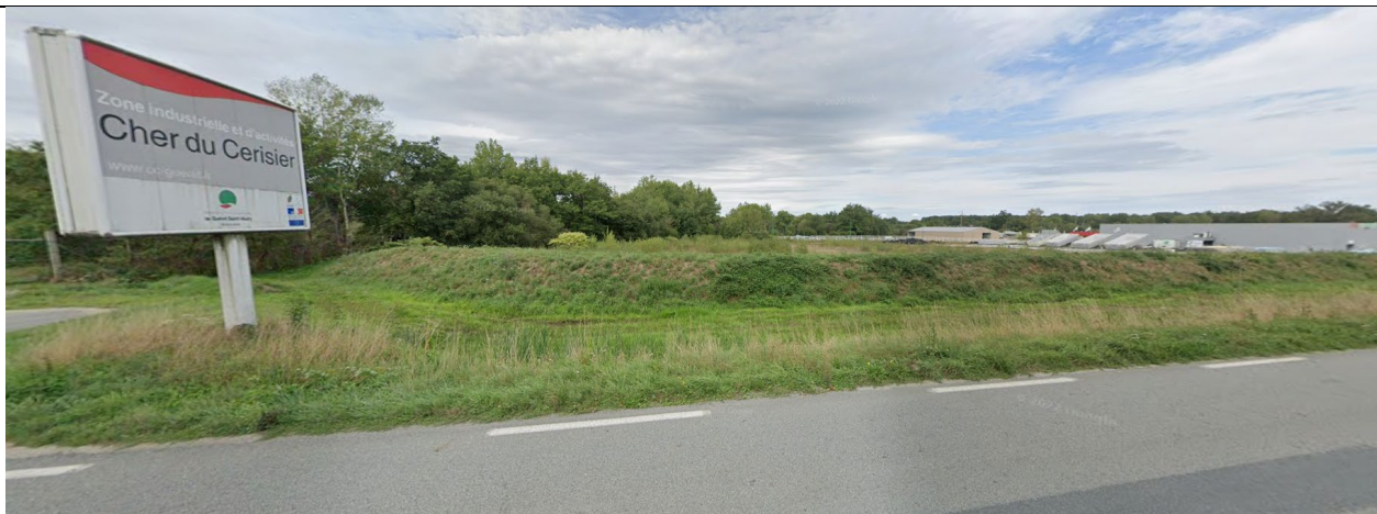
PFU de la première tranche de la zone du Cher du Cerisier, vu depuis la RD 940 (source : Google street view)
