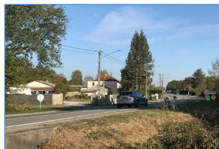
Entrée de ville au sud de Planchemoreil
