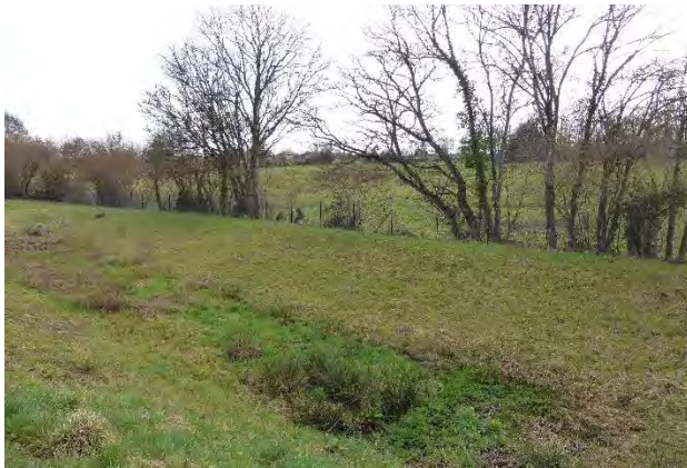
Bassin de rétention quasiment à sec sur la parcelle ZA0350 (ECTARE)
