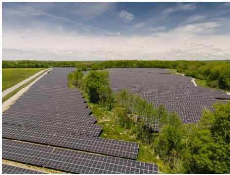
@EDF Renouvelables / Remi Flament
