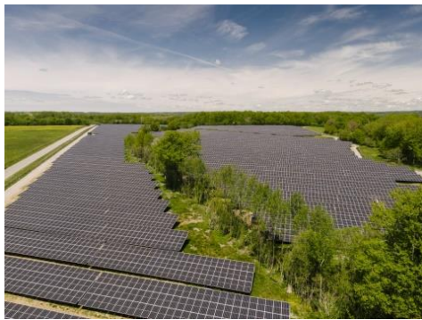
@EDF Renouvelables / Remi Flament
